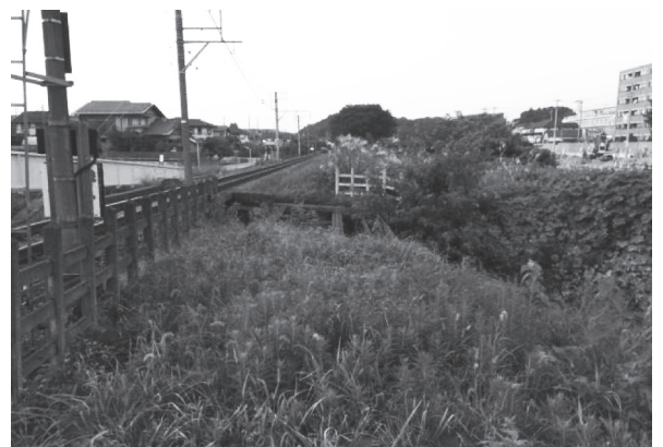
図-2（図-1）と同じ場所。奥がこどもの国方面、手前方向に恩田駅方面。線路右側の鉄橋が旧線
