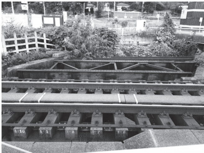
図-1 こどもの国～恩田駅間の線路。左方向にこどもの国駅、右方向に恩田駅。手前が現在の線路、奥が旧線。
