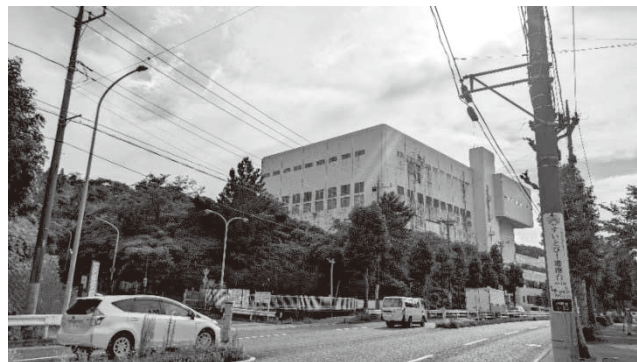
大きな建物が、旧港南工場。ここに新病院が建設される予定です。
